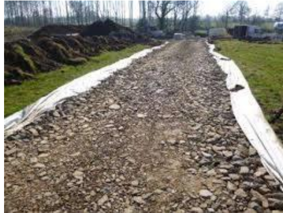
Exemple de piste provisoire sur géotextile
