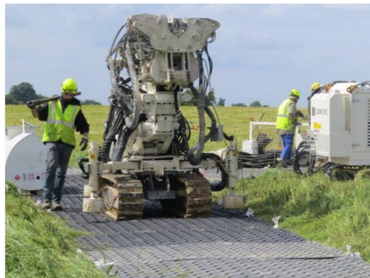
Exemple d'accès provisoire sur plaques en métal
