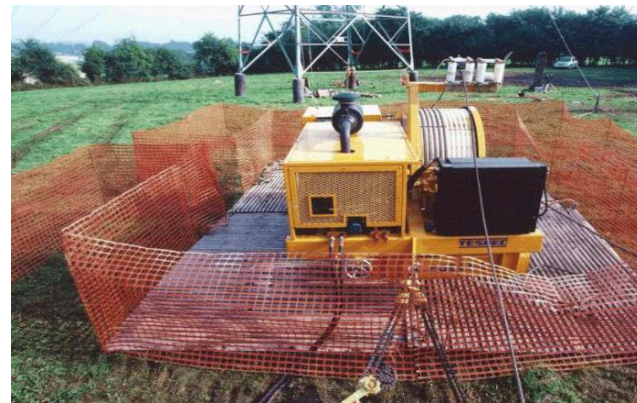
Exemple de plateforme de déroulage et de travail
