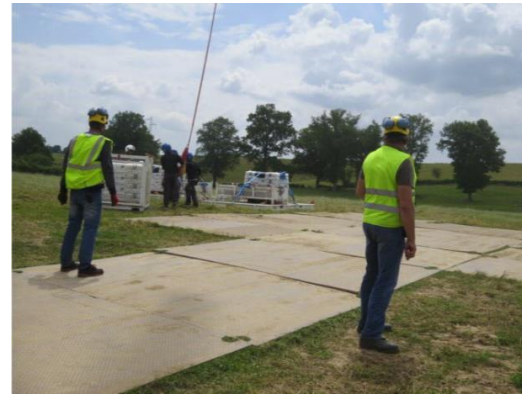
Exemple d'accès provisoire sur plaques en bois
