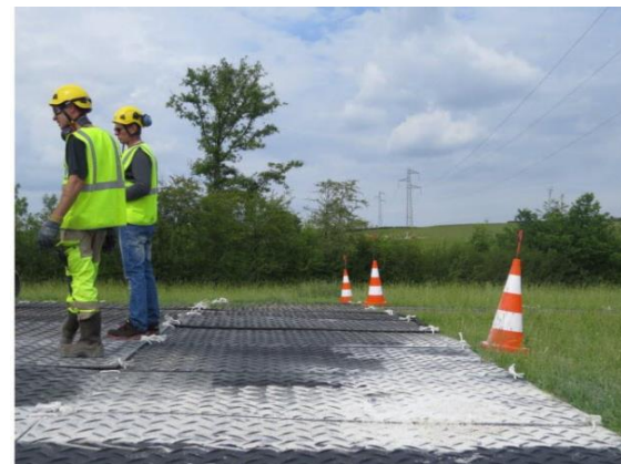
Exemple d'accès provisoire sur plaques en caoutchouc
