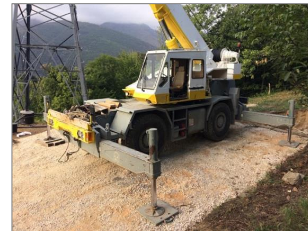
Photos illustrant les opérations de montage et levage d'un support
