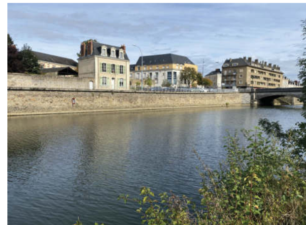
8 - Vue du quai en aval du pont Yssoir depuis la rive opposée
