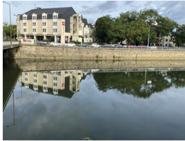
10 - Vue du quai en amont du pont Perrin depuis la rive opposée
