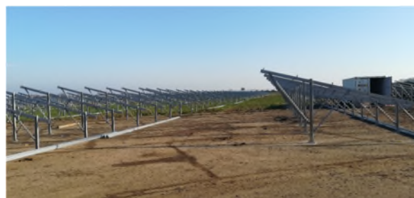
Ancrages pieux béton
