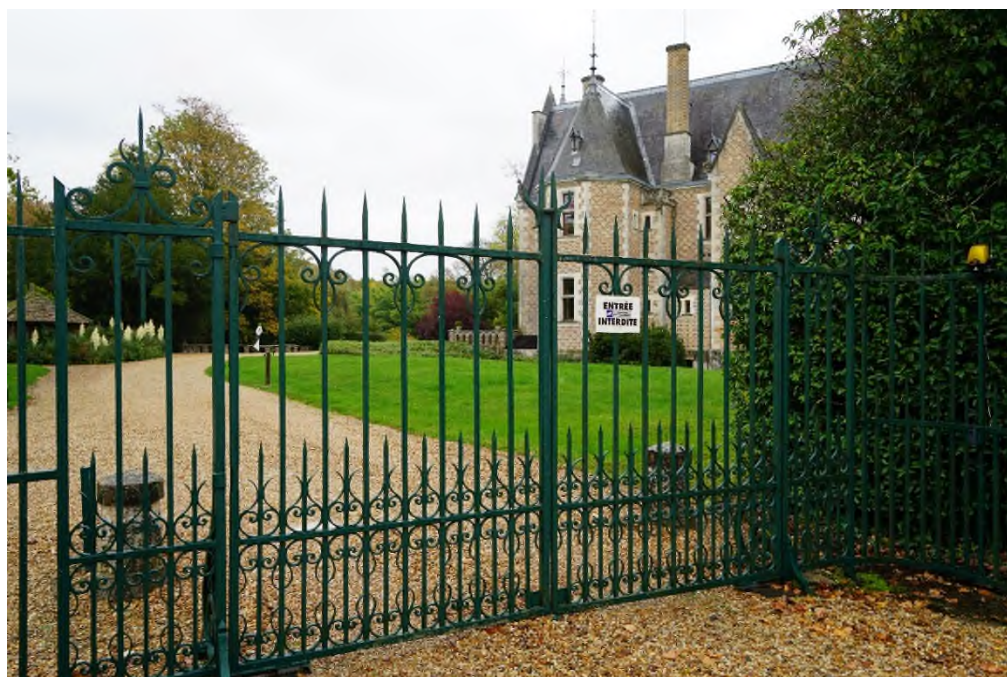
Figure 115 : Château de Nançay Source : ADEV Environnement
