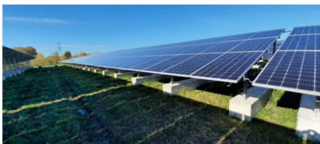
Longrines béton, centrale photovoltaïque des grandes Jonchères
