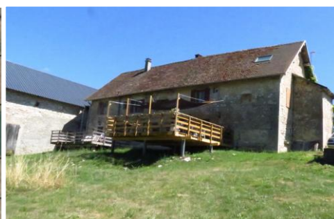
Coté marais, l'arrière de l'auberge, avec les 2 terrasses, celle de 40 m 2 au 1 er plan
