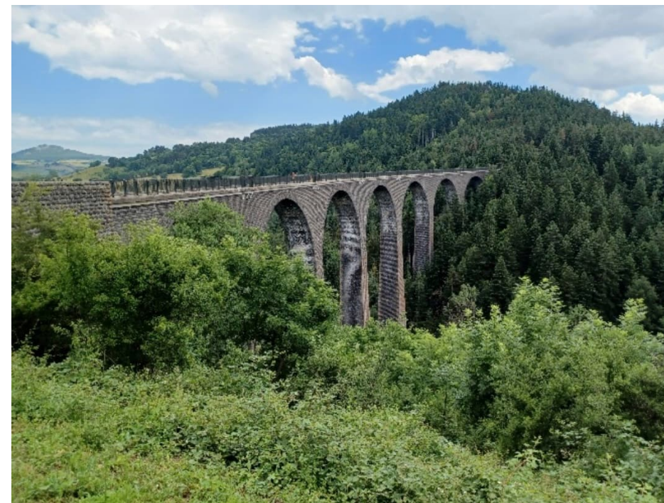
Photo 17 : Viaduc de la Recoumène, Le Monastier-sur-Gazeille, 10-07-2024
