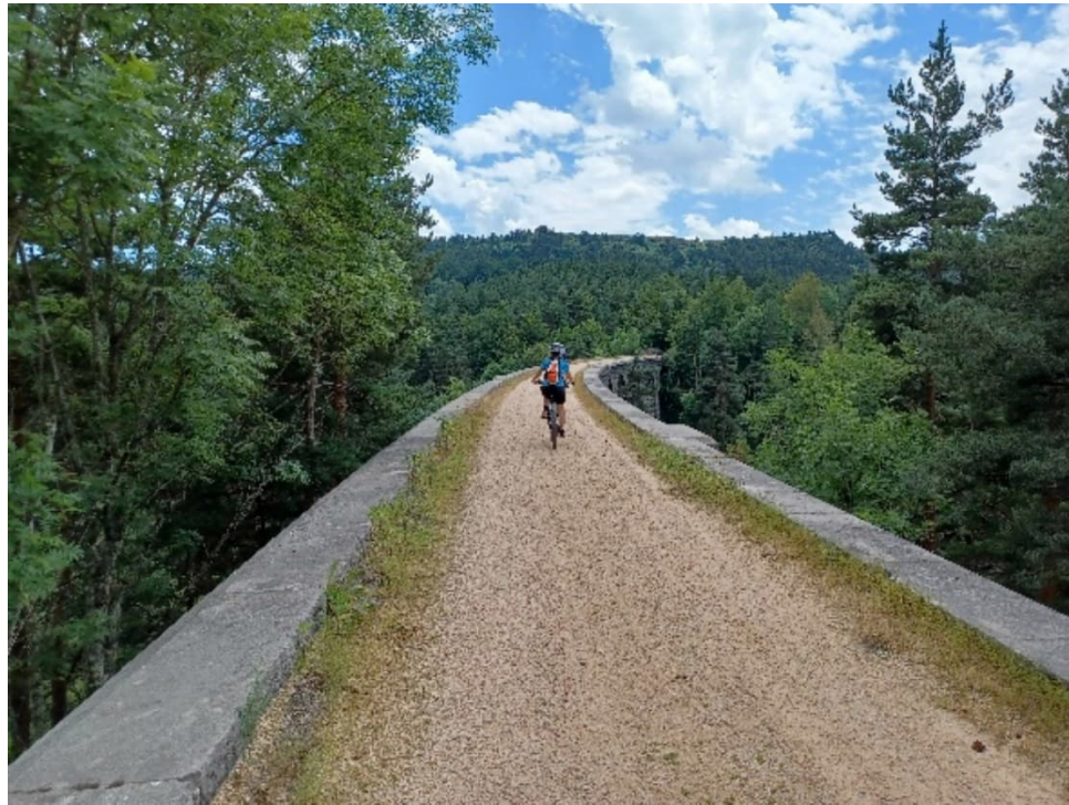
Photo 13 : Viaduc de Fontfreyde, Laussonne, 07-10-2024
