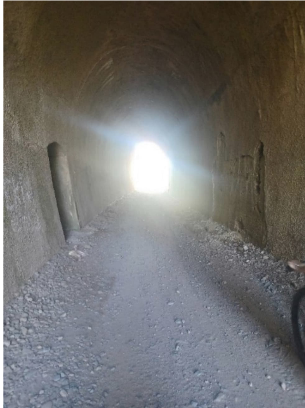
Photo 7 : Tunnel du Priouret, Saint-Germain-Laprade, 29-08-2024
