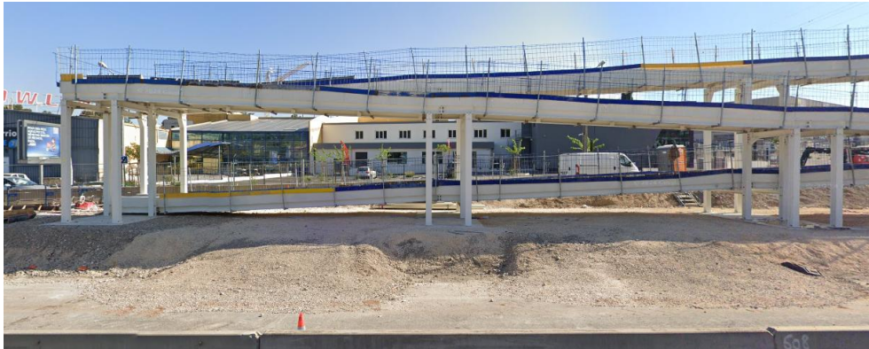
Figure III-11 : Exemple de rampe sur pilotis - scénario n°2
