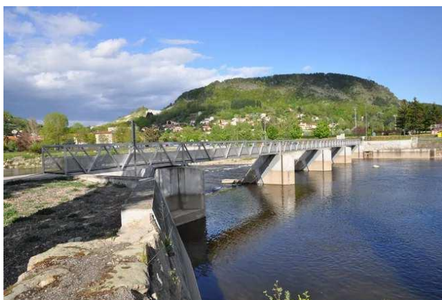
Figure I-4 : Photo de l'ouvrage de franchissement – Vue amont
