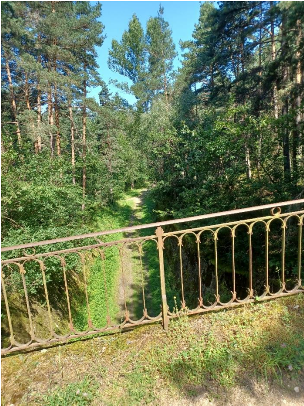
Garde-corps sur ouvrage existant au-dessus de la Transcévenole
