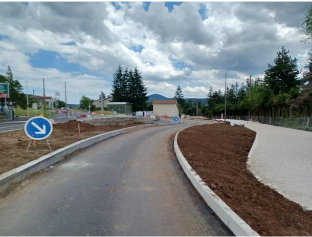
Travaux urbains à le Monastier-sur-Gazeille (juillet 2024)
