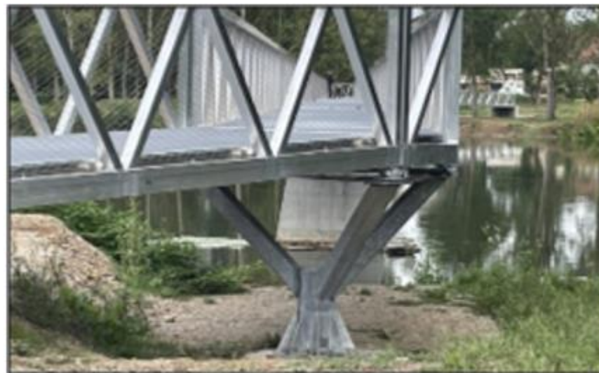
Photo 12 : Solution retenue : Réhausse des appuis
