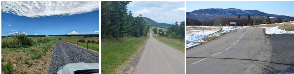
Photo 9 : Sur le tracé de la section 9 – Boucle nord
