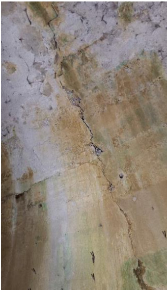
Photo 18 : Affouillement en pied de pile
