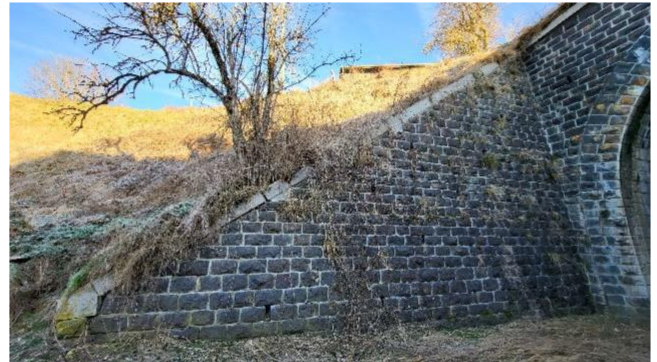
Photo 43 : Arbres sur le mur en aile d'une tête du tunnel d'Avouac (source : diades, 2024)
