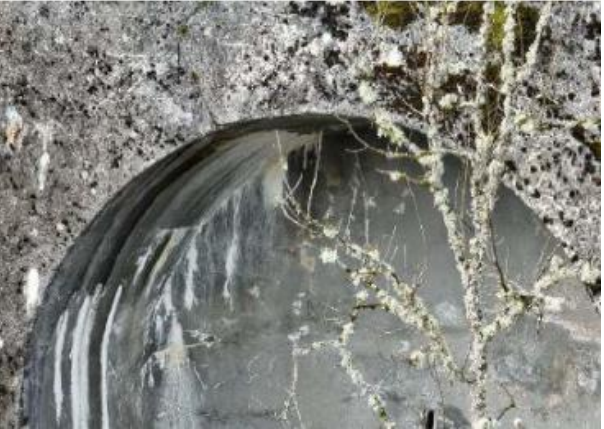
Photo 22 : Calcite et coulure d'eau
