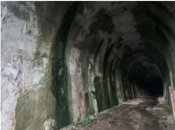
Photo 17 : Vues d'eau en voûte et écoulement de l'eau sur le radier
