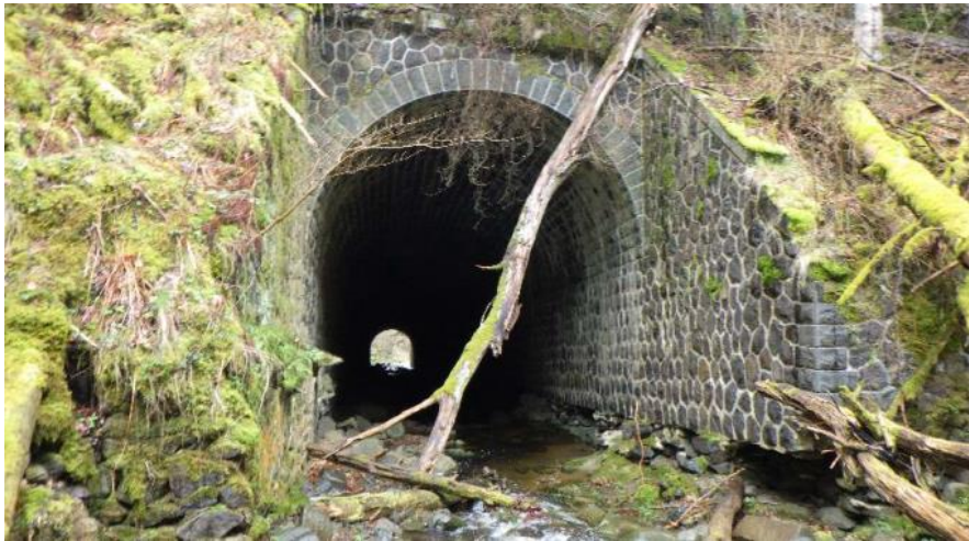
Photo 36 : OH35 (source : fiche inspection détaillée 2023)
