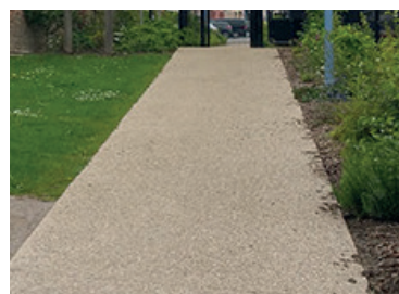
Exemple de revêtement de trottoirs et voie cycle en béton désactivé Source : La Voie du Nord - Article sur Beuvry
