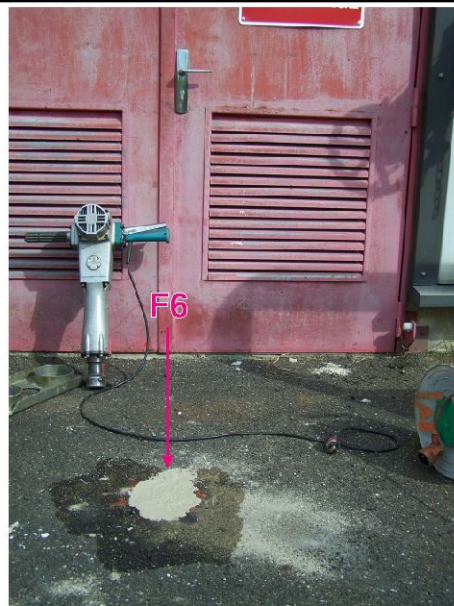
Forage F6, rebouché
