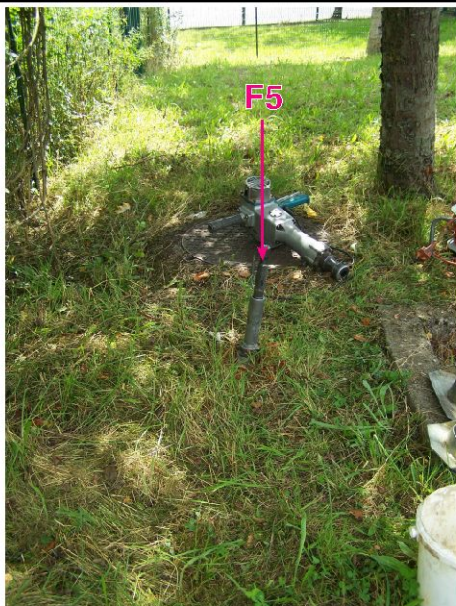
Forage F5 près du séparateur d'hydrocarbures du parking pour véhicules légers
