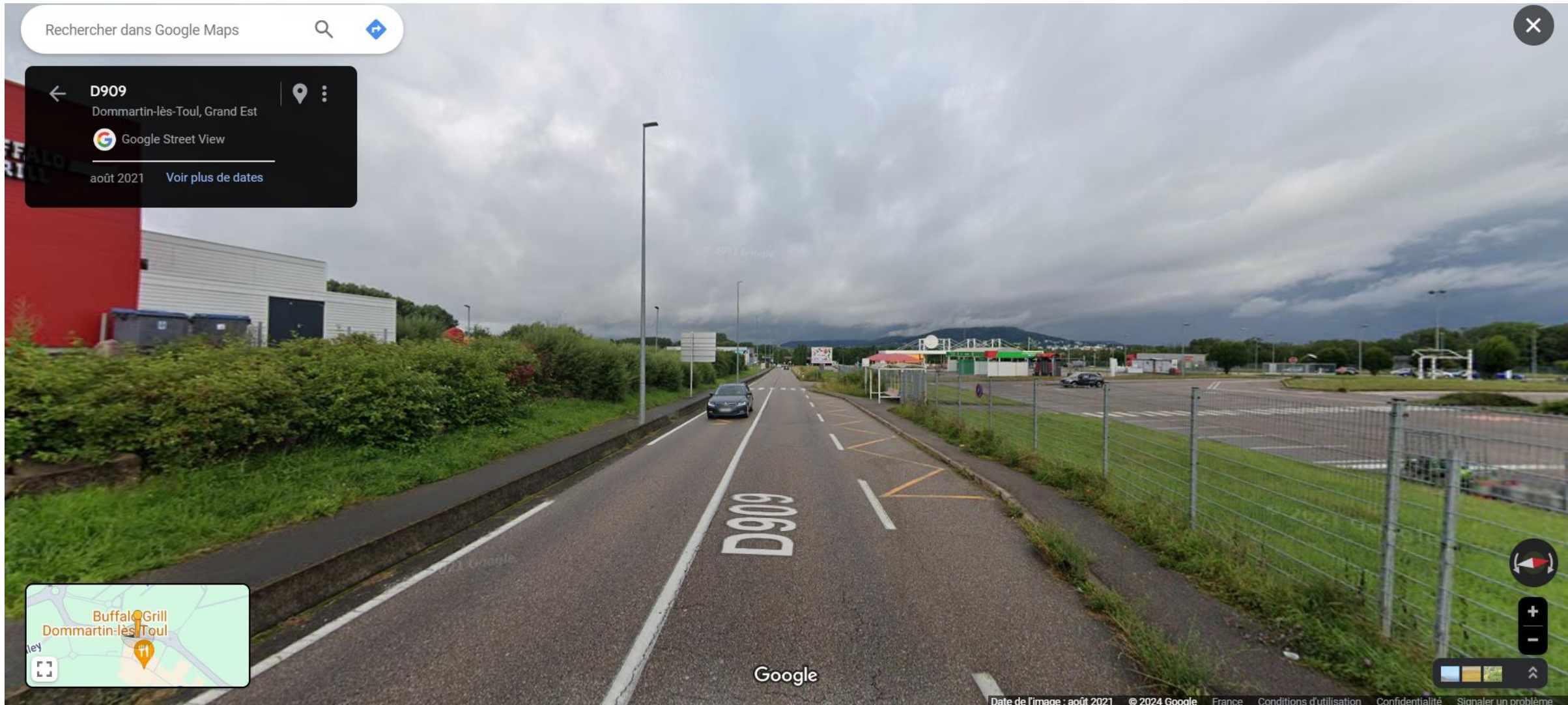
PHOTO 3- RD 909 qui va être transformée en voie exclusivement réservée aux mobilités douces
