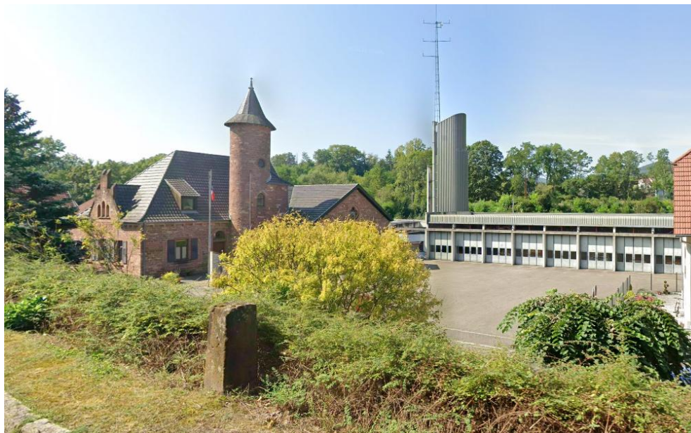
Vue du Centre d'Incendie et de Secours à partir de la RD662
