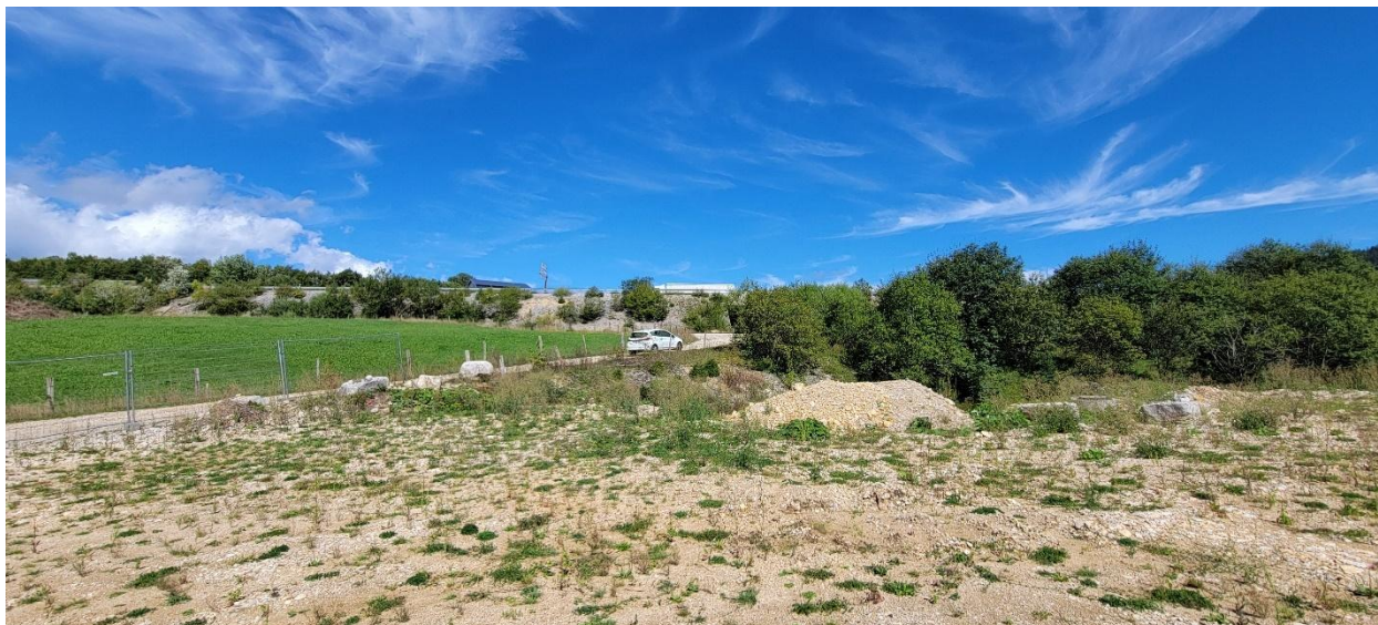
Photo 7 : Vue depuis la plateforme actuelle
