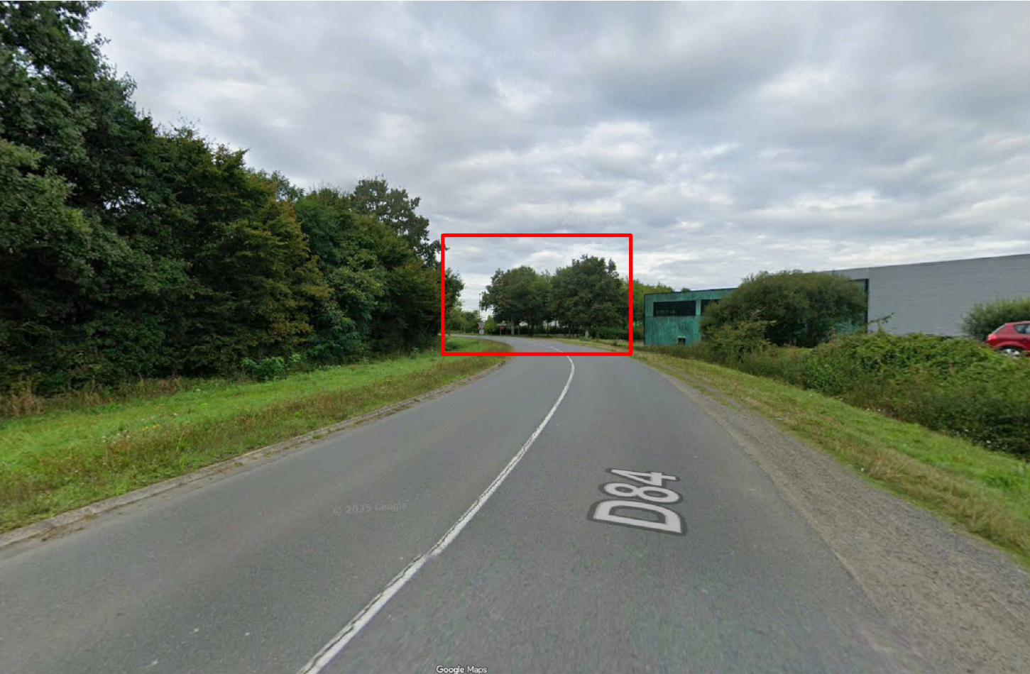
Vue C - Vue éloignée Sud-Est, depuis la RD84 (Google maps sept. 2024)
