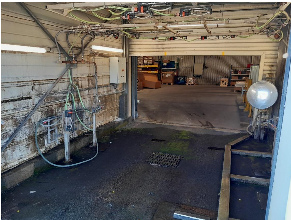
PHOTOGRAPHIE DE LA ZONE DE TEST D'ETANCHEITE (EMPLOI D'EAU UNIQUEMENT)
