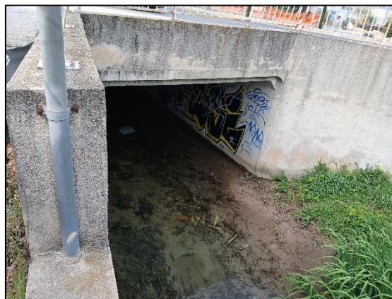
Couverture à l'ouest de la zone d'étude
