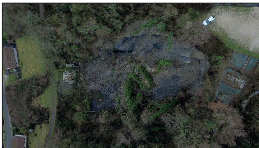
Figure 5. Vue verticale de l'évènement avec parking aval, station de traitement et habitations avals
