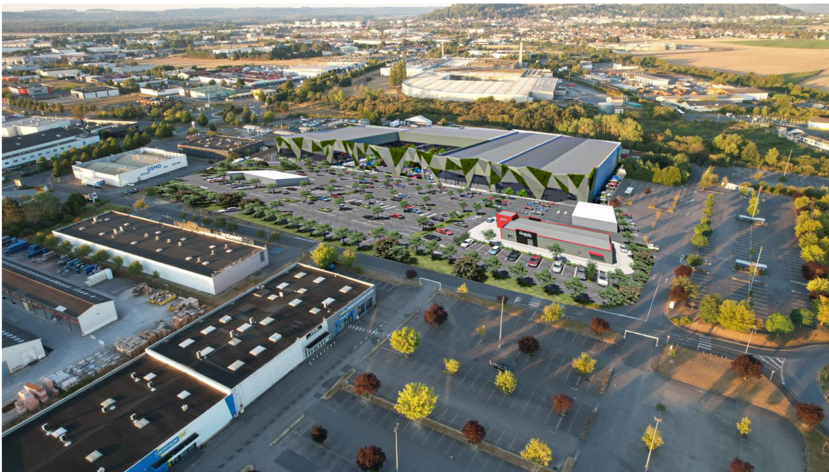
Vue de drone 26/03/2026 projet
