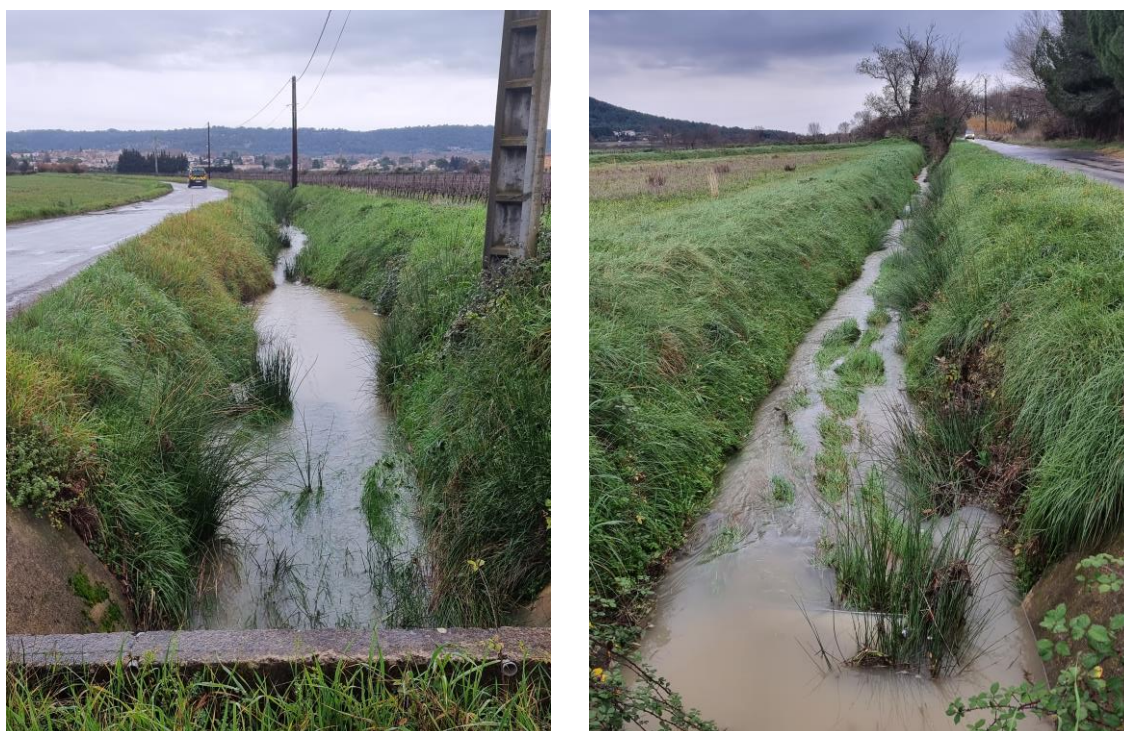
Figure 3 : Photographies du Valat du Tal au droit de la station actuelle de traitement des eaux usées de Clarensac (source : CEREG, Janvier 2023)
