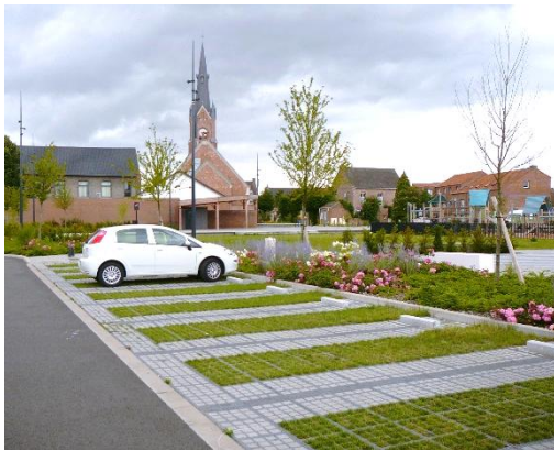
Figure 11: Revêtement perméable modulaire : Les dalles alvéolaires (ADOPTA)
