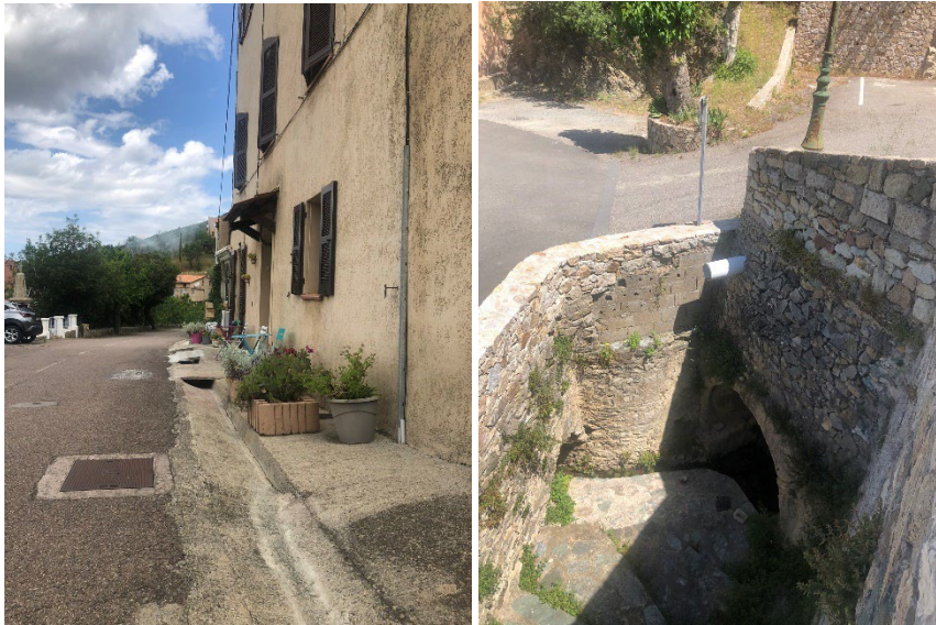
Caniveau aérien dans le village et exutoire
