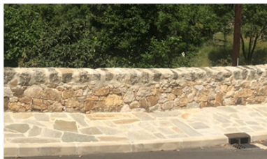
Exemple de parapets à l'entrée du village
