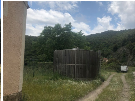
Cuve DFCI Gare
