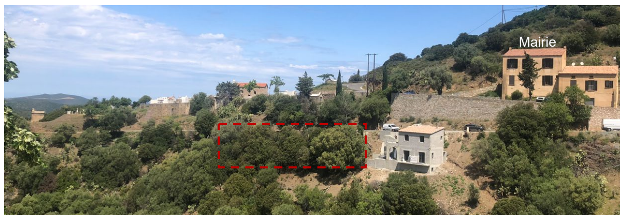
Localisation de la parcelle impactée par la zone UD – photo 2025
