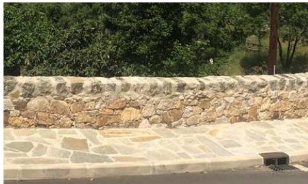
Exemple de parapets à l'entrée du village
