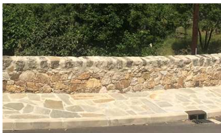
Exemple de parapets à l'entrée du village
