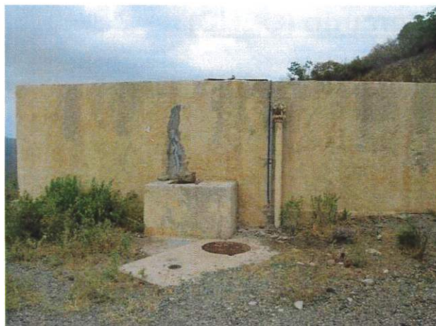
Extérieur réservoir OEHC
