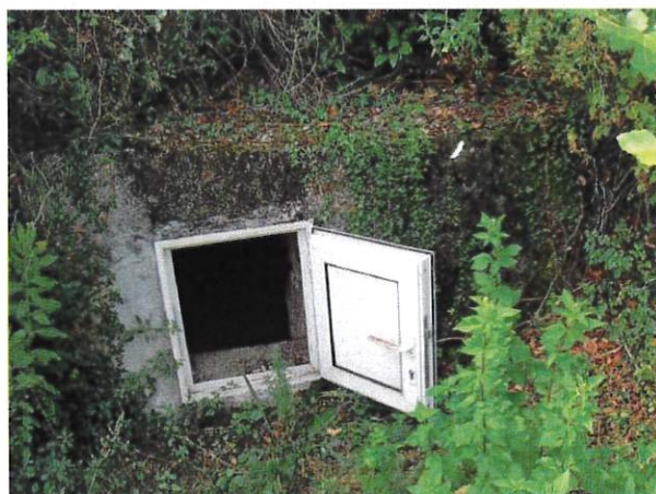
Porte d'accès au captage n°2
