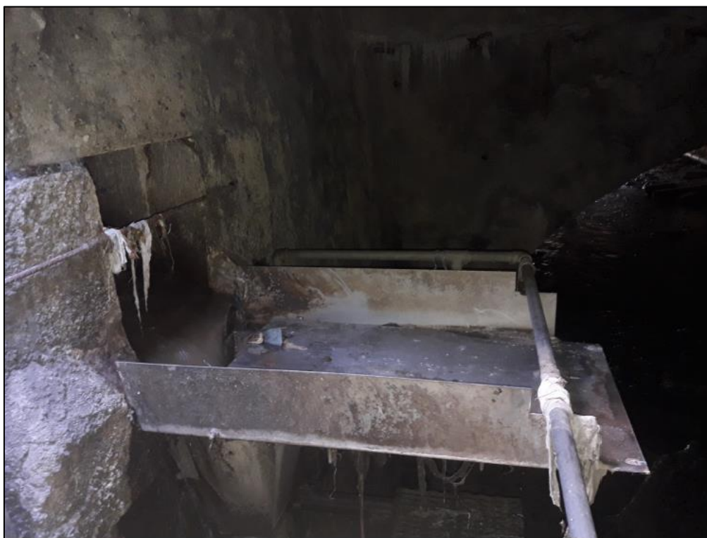
FIGURE 1 – DO 1.10 «REPUBLIQUE» A VOIRON – PHOTOGRAPHIE PRISE LORS DE L'ETABLISSEMENT DES FICHES DO PAR ATEAU.
