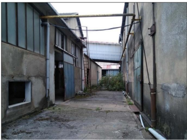
2 - Vue vers l'Ouest entre le garage (à droite) et la chaine Frappaz (à gauche)
