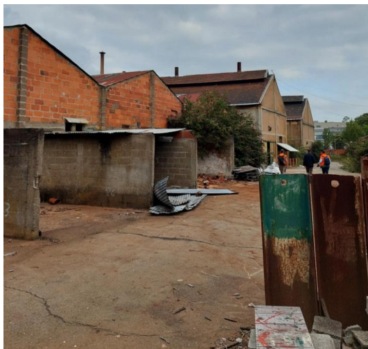
5 - Vue vers le nord sur l'arrière des bâtiments : Atelier Fil et injection plastique
