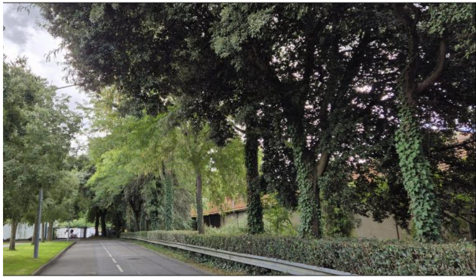
2 - Vue sur les vestiaires à droite depuis la rue des Boires
