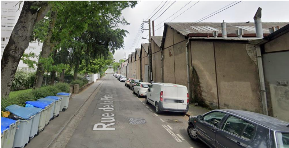
4 - Vue sur les sheds au nord du site vers la rue de la Porte Gellée
