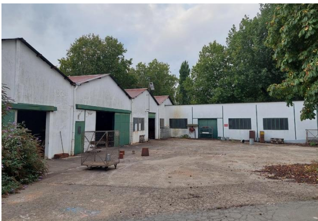
3 - Vue vers le Sud sur les ateliers Serrurerie, injection plastique et Atelier Fil
