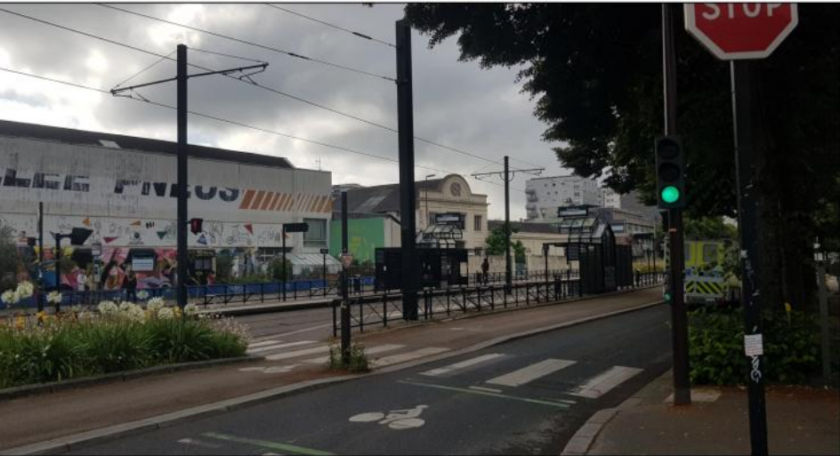
5 - Vue sur le bâtiment principal Guillaouard depuis le Bd des Martyrs côté Nord-Ouest
