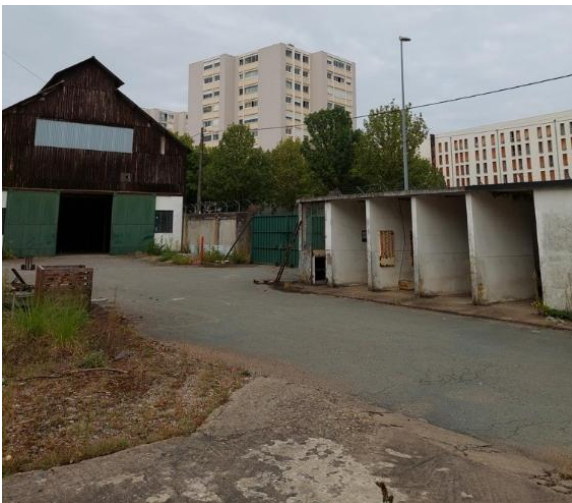
6 - Vue sur l'accès à la rue de la Porte Gellée et le garage
