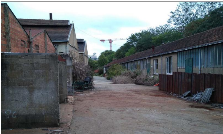
1 - Vue vers le Nord et le bâtiment vestiaire qui longe toute la limite Est
