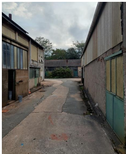
4 - Vue vers le nord sur le bâtiment vestiaire, et Atelier Fil à droite
