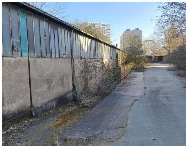
7 - Vue sur la rampe d'accès menant au sous-sol des vestiaires
