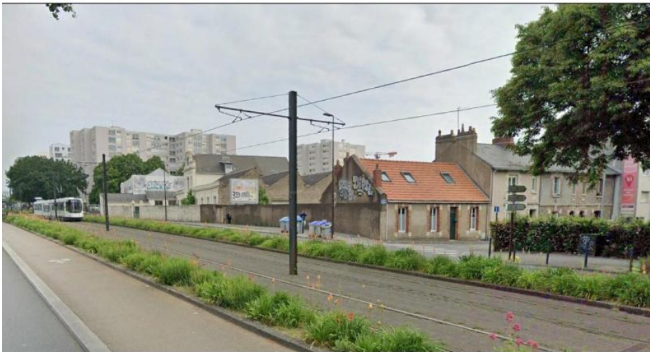
7 - Vue sur le bâtiment principal Guillaouard depuis le Bd des Martyrs côté Sud avec les maisons individuelles
