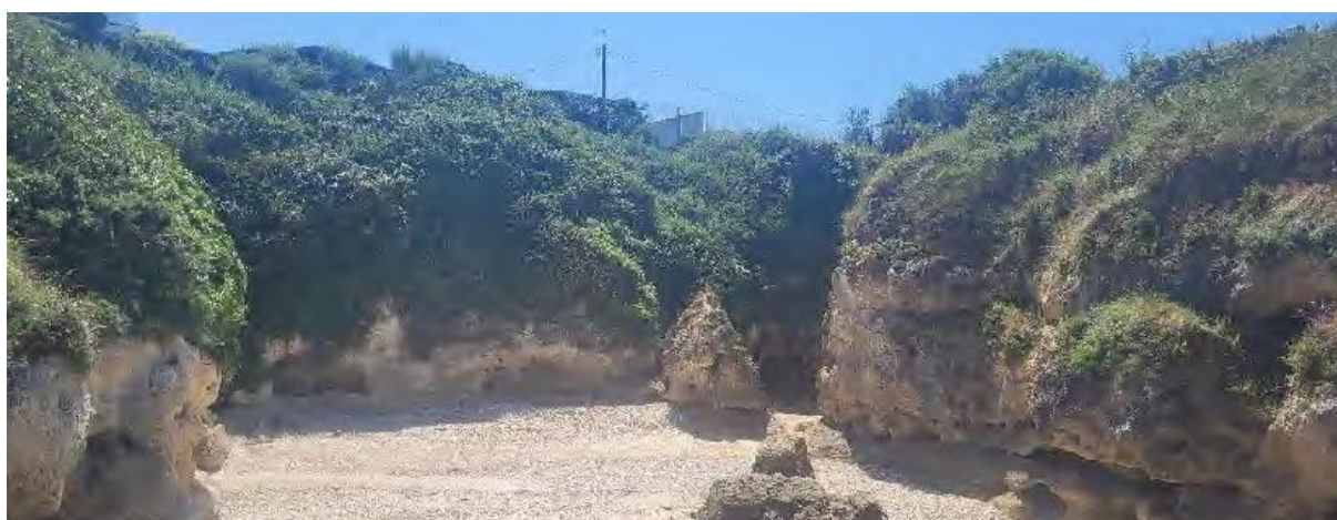
Photographie du secteur 6 depuis l'aval – Prise le 17/06/2025 par GEOTEC
