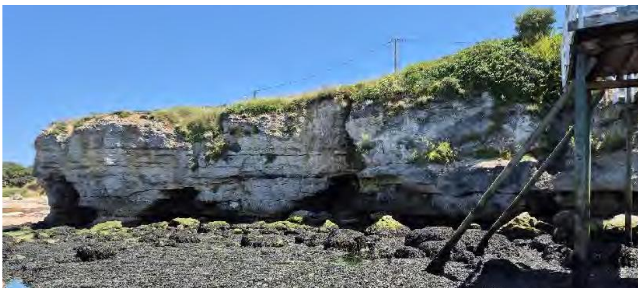
Photographie du secteur 5B depuis l'aval – Prise le 17/06/2025 par GEOTEC
