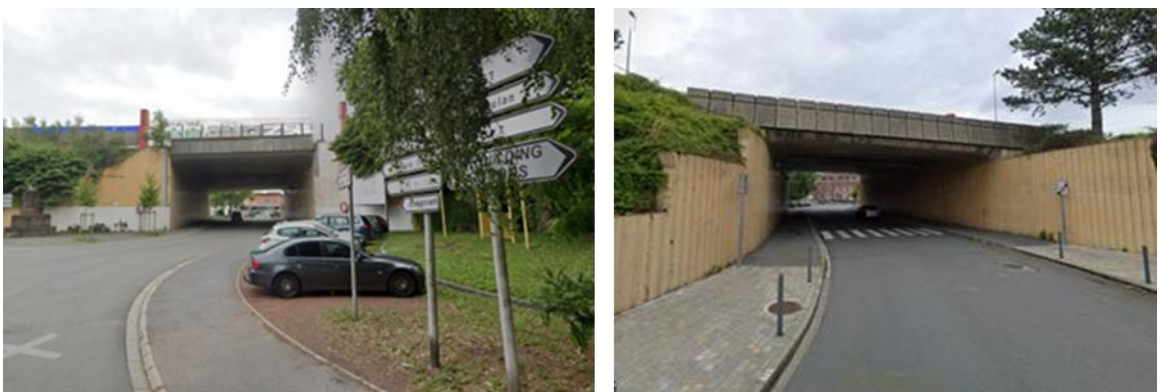
Figure 4: Illustrations de l'état existant passage sous l'A21
