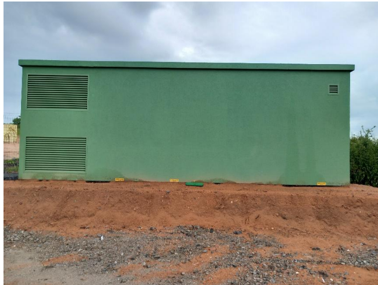
FIGURE 5. EXEMPLE DE POSTE DE LIVRAISON AVEC TALUS
