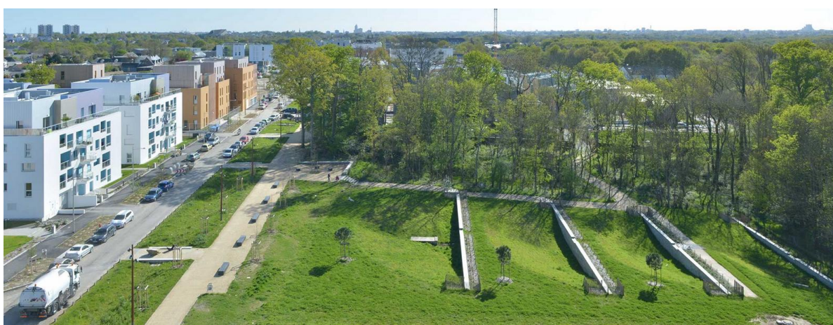
Figure 17 - exemples de bassin d'orage extensif et enherbé, de haut en bas : bassin paysager de la zone artisanale de Bellevue ( leprogres.fr ) et bassin d'orage paysager à Nantes ( Nantes Métropole )
