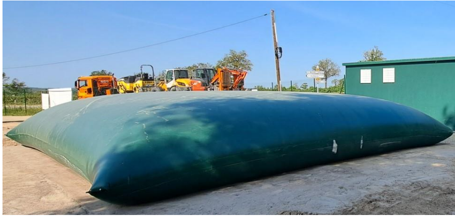
FIGURE 8. EXEMPLE DE CITERNE INCENDIE POUVANT ETRE MISE EN PLACE
