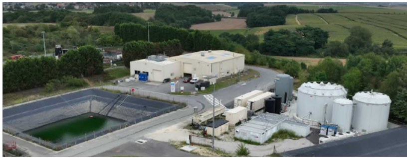
Installation de traitement des lixiviats (NPNT, p.36)
