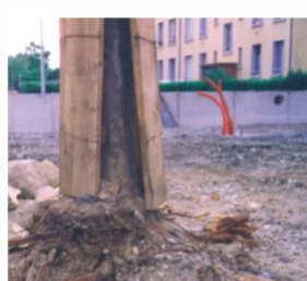
Protection insuffisante contre les dégâts sur les racines et le tronc
