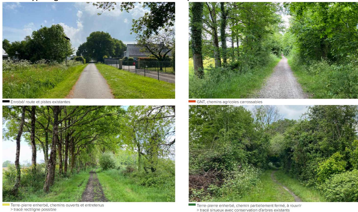
Figure 2. Typologies de revêtement actuel de l'emprise de l'ancienne voie ferrée (source : COLOCO 2025)
