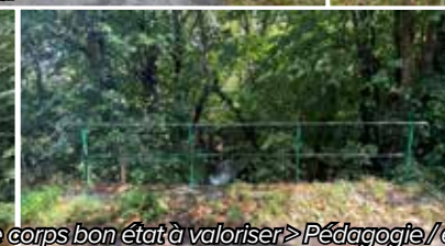
Ouvrage hydraulique maçonné - Garde corps bon état à valoriser > Pédagogie / eau
