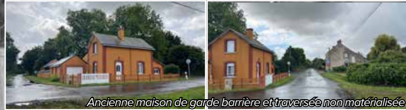
Ancienne maison de garde barrière et traversée non matérialisée
