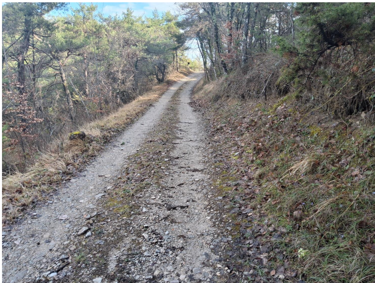
Chemin existant sur un tronçon d'Aubenasson ( Photo mars 2026 )
