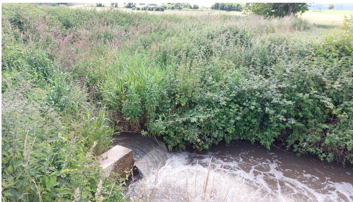
Figure 5 : Ouvrage et seuil existant sur le Barbaillon, bordure nord de la parcelle
