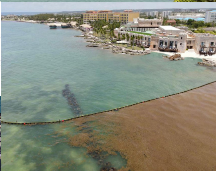
Installation de la barrière Mursargaz dans un hôtel
