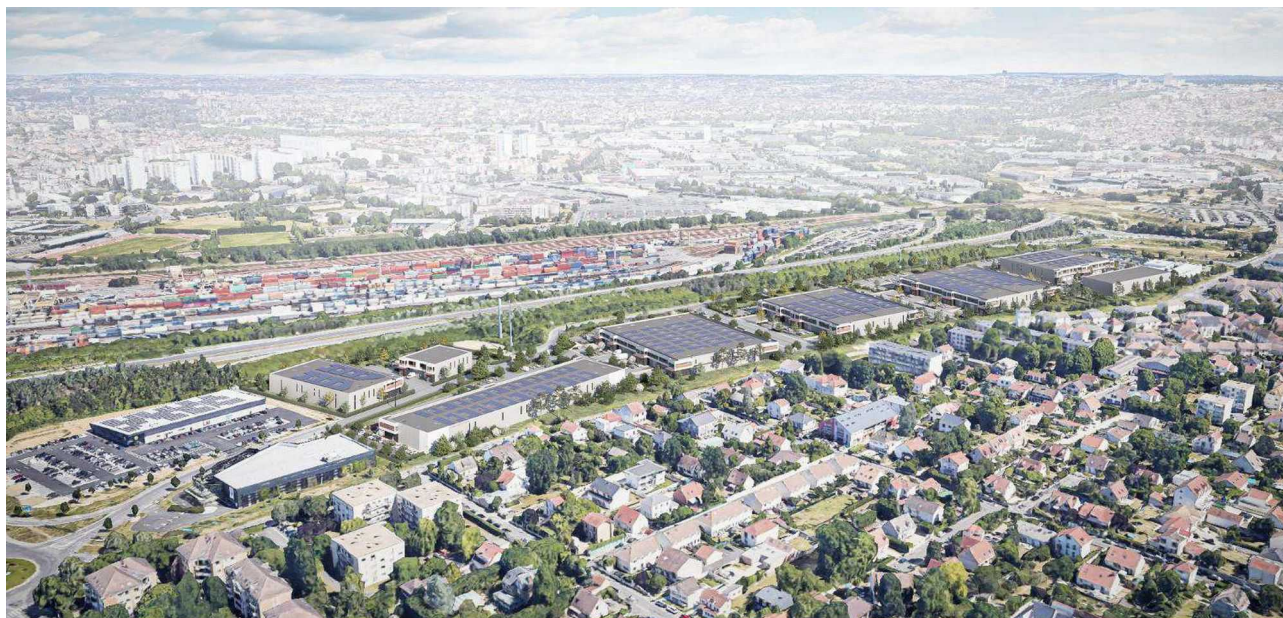
Vue aérienne du projet de création d'un parc d'activités à Bonneuil-sur-Marne au sein de la zone d'aménagement concertée (ZAC) Bonneuil sud.
