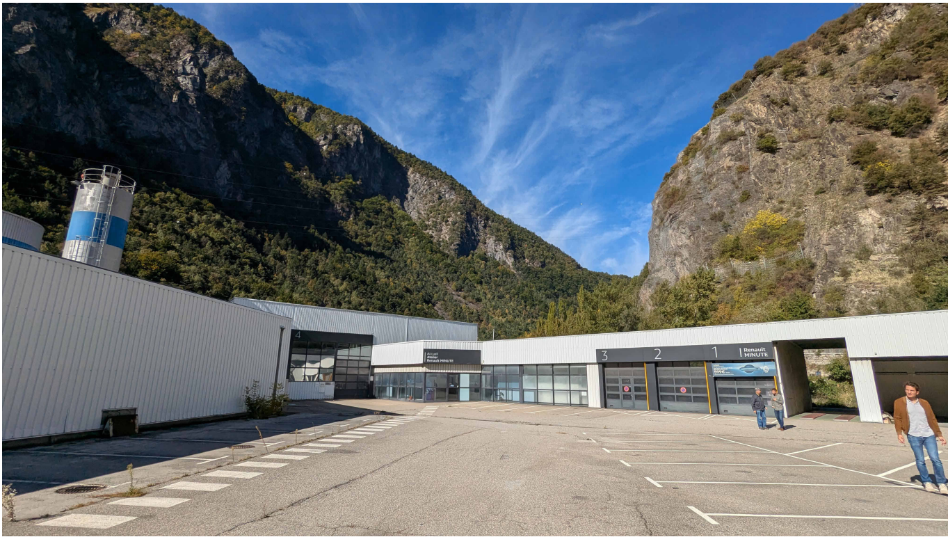
Photographie proche PP2_ Vue avant du bâtiment existant
