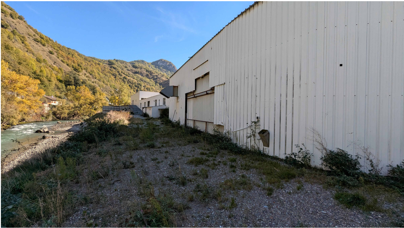
Photographie proche PP1_ Vue arrière du bâtiment existant
