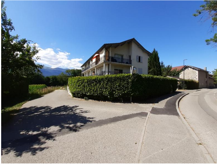
Figure 9 : Vues sur l'accès (parcelle BA128), l'environnement bâti immédiat, et le Jura en arrière-plan, depuis la route de Vésegnin ; le site est peu visible. Photographie BLC, 07/2025
