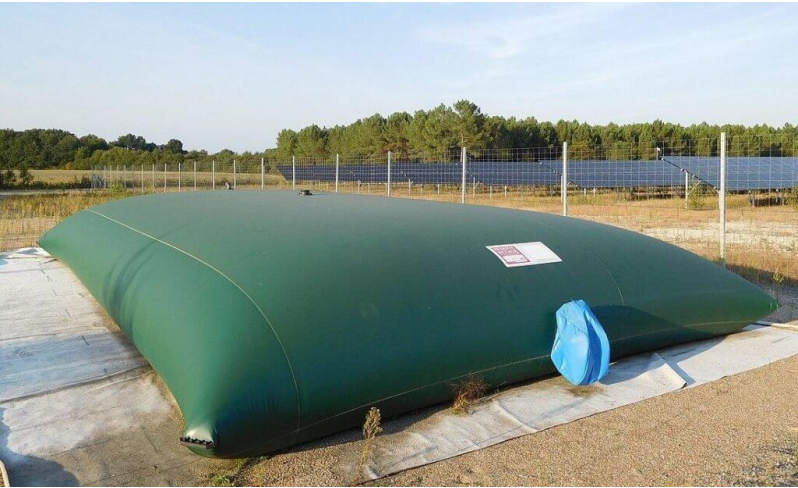
Figure 25 : Citerne incendie (source : maciternesouple.fr)
