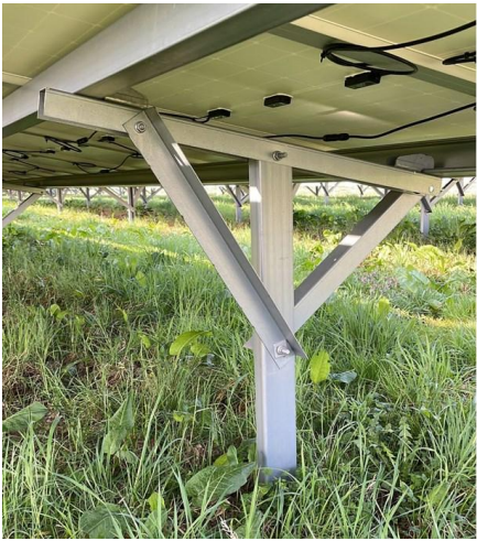
Figure 20 : Pieu battu (source : Siguesol)
