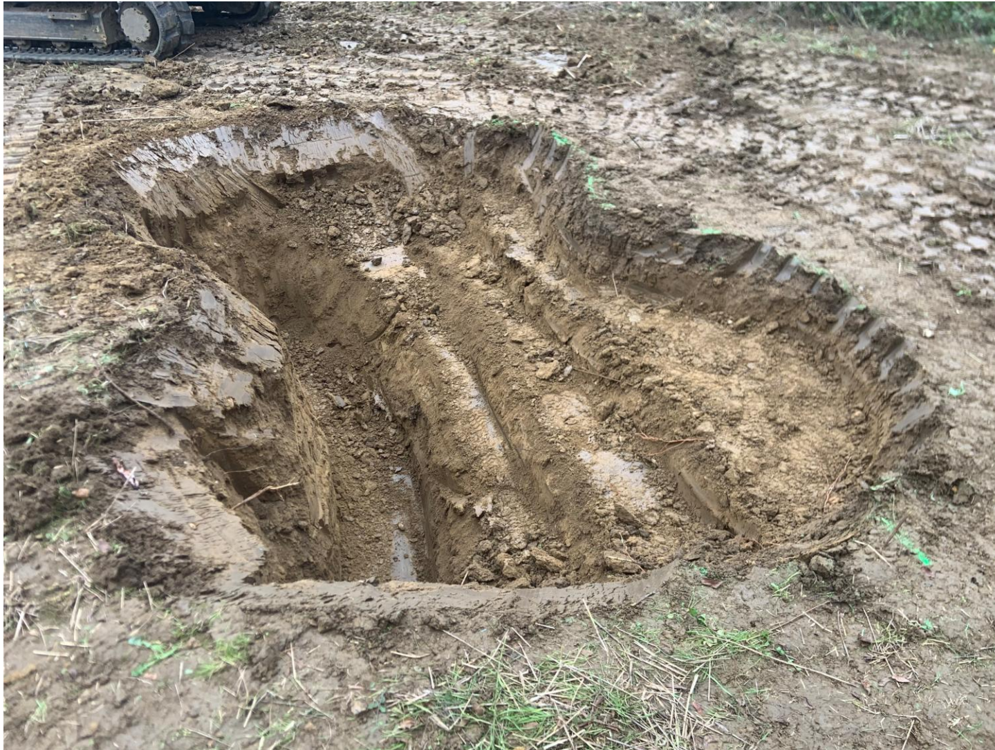
Figure 50 : Terrassement d'une mare selon les principes de création susmentionnés (photographie prise hors site - © SIRE Conseil)
