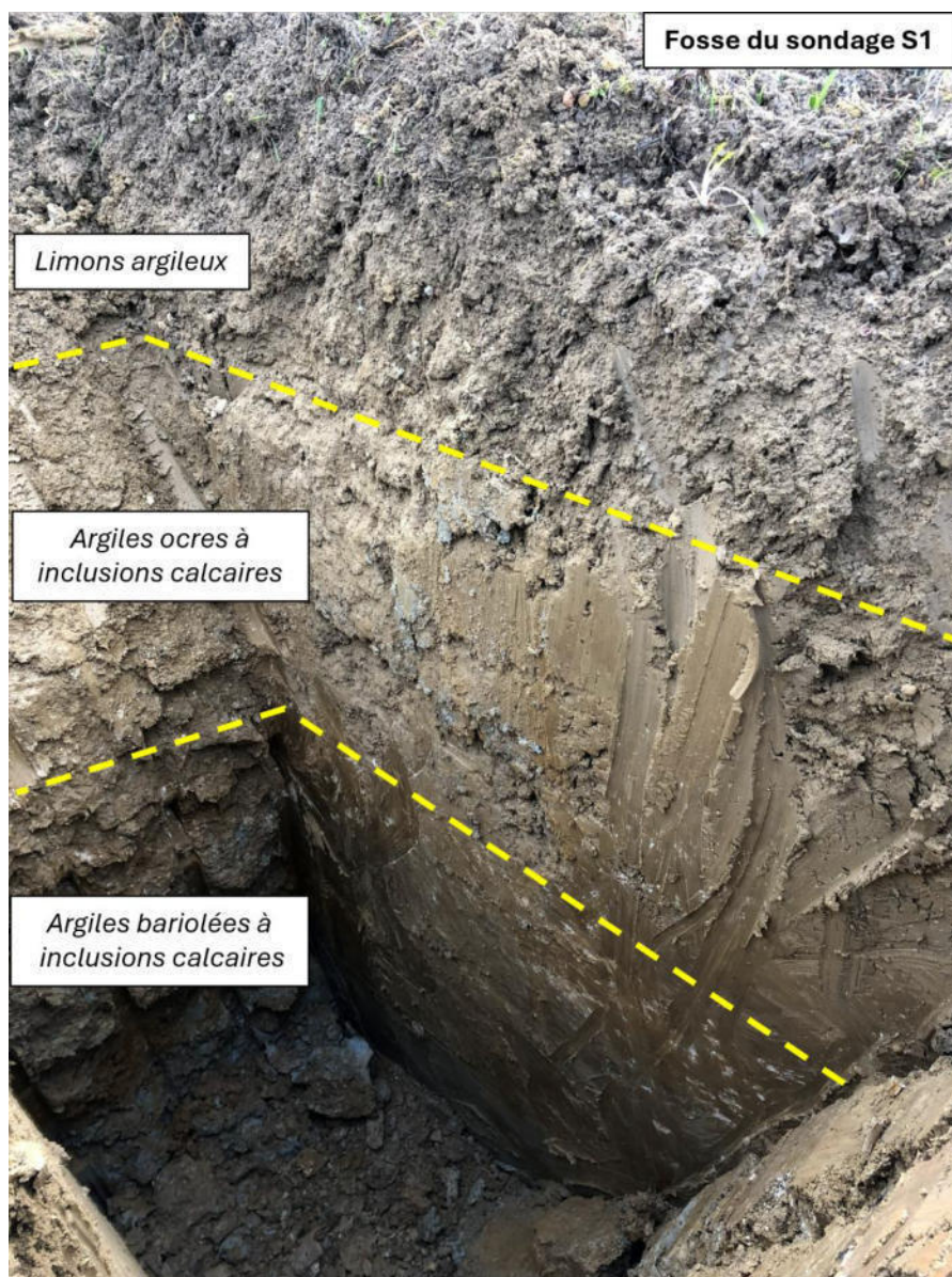
Figure 3 : Cliché de la fosse du sondage S1 (GESOLIA)
