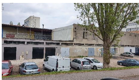
Abords de bâtiment
