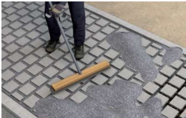
Figure 10 : Principe des dalles pavées drainantes
