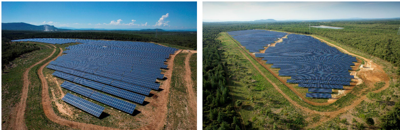
Figure 5 : Centrale solaire de Belvesol dans le Gard (20 MWc)
