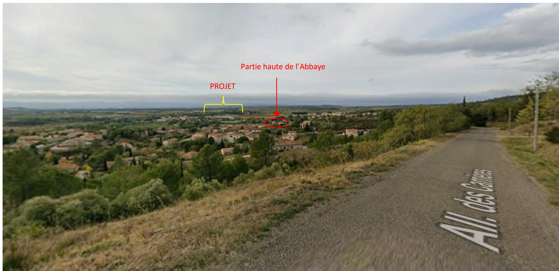
Vue 4, depuis Allée des Carrières (distance au projet \approx 1\,000 m) – Covisibilité très limitée entre le projet et le toit de l'Abbaye, compte tenu de la distance et de son positionnement derrière les bâtiments du SDIS et l'Écomusée (qui sont par ailleurs des bâtiments avec un aspect industriel)
