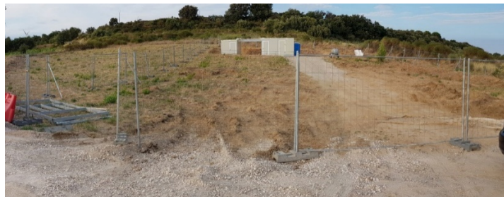
■ Figures 7 : Exemple de clôture mobile pour le balisage de l'aire de chantier
