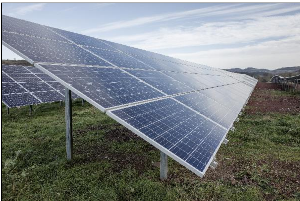
Photo 1 : Structures en pieux battus - Parc Solaire de Camares (12) – SDMD
