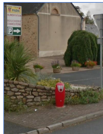
Photo 2 : Photo de la borne incendie
